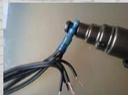
6.5. Разогревайте припой до тех пор, пока муфта не начнет сжиматься, и сам припой не начнет плавиться и стекать в медный наконечник. После того, как припойное кольцо полностью расплавится, продолжайте нагревать примерно 6 секунд. На выполнение всей процедуры коммутации в зависимости от условий работы затрачивается от 2-х до 3-х минут.
